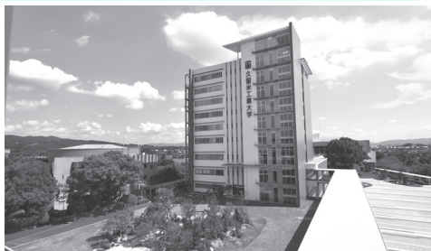
2015年に完成した新棟
