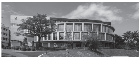
総合新校舎「楽工舎」（2017年9月完成）
