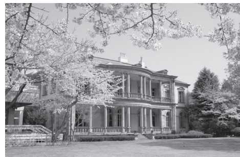
国の重要文化財に指定された本館 (旧島津家本邸)
