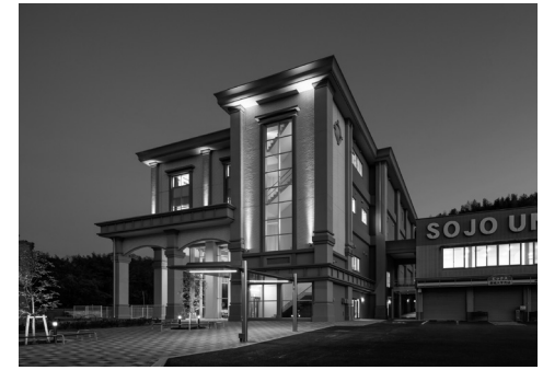
薬学部新講義棟完成
