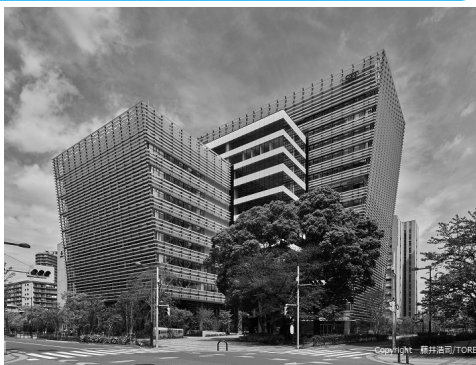
2022年4月竣工の豊洲本部棟
